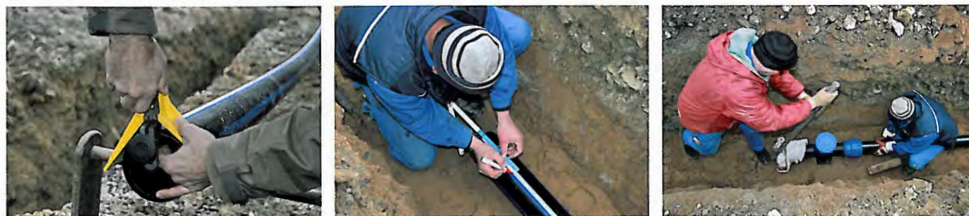
Bild 2: Einfaches Handling ist einer der Vorteile der Steck-Verbindungstechnik: Rohr anfasen, Einstecktiefe markieren und auf gereinigtes Rohr aufschieben
